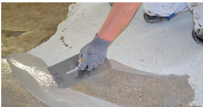
Detail povrchu po aplikácii vyrovnávacej stierky
