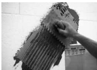
3.20 Detail prevedenia prídavnej výstuže v rohoch otvorov
