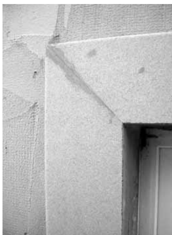
5.5 Detail - aplikácia polystyrénových prírezov
