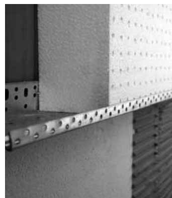
5.1 Detail riešenia zateplenia v soklovej oblasti
