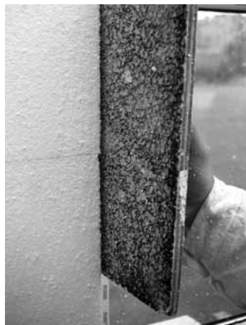
3.13 Brúsenie izolačných dosiek
