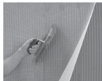
4.12 Vtláčanie sklotextilnej sieťky do armovacej vrstvy
