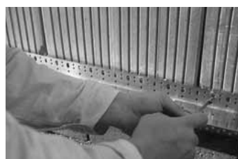
4.4 Montáž soklového profilu - kotvenie
