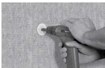
4.9 Uťahovanie skrutkovacích kotiev
