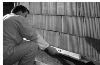
4.3 Montáž soklového profilu - meranie rovinnosti
