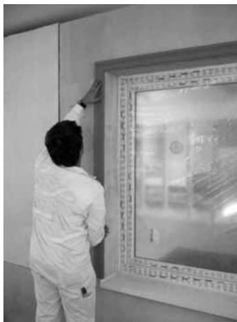
5.4 Aplikácia prefabrikovaných fasádnych profilov
