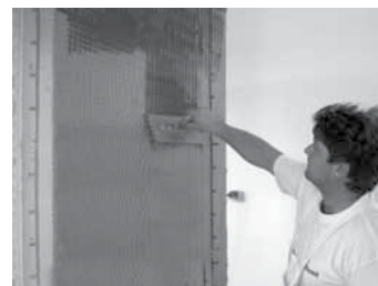
4.11 Vytvorenie armovacej vrstvy
