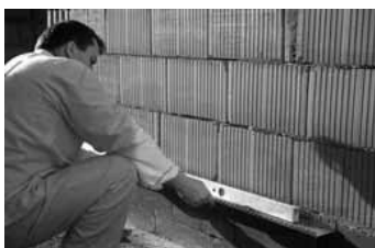
3.3 Montáž soklového profilu - meranie rovinnosti
