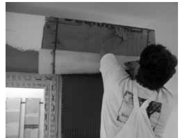
3.16 Aplikácia sklotextilnej mriežky do výstužnej vrstvy
