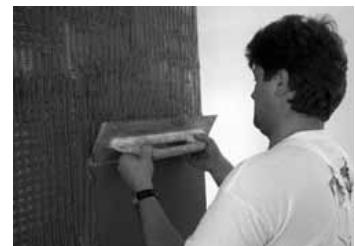
3.18 Zarovnanie výstužnej vrstvy
