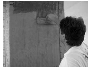
3.17 Vtláčanie sklotextilnej mriežky do výstužnej vrstvy
