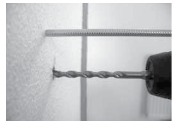
3.11 Vrtanie otvorov pre osadenie kotiev
