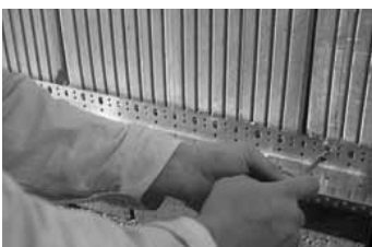
3.4 Montáž soklového profilu - kotvenie
