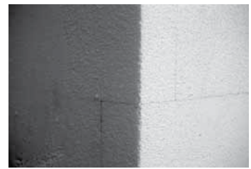
3.9 Kladenie izolačných dosiek pri nároží
