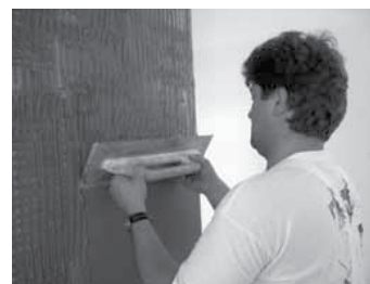
4.10 Vytvorenie vyrovnávajúcej vrstvy
