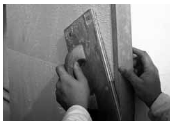
3.14 Brúsenie izolačných dosiek
