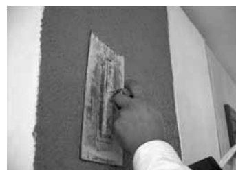
3.24 Vytváranie štruktúry na tenkovrstvovej ušľachtilej omietke
