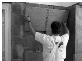
4.6 Kladenie izolačných dosiek
