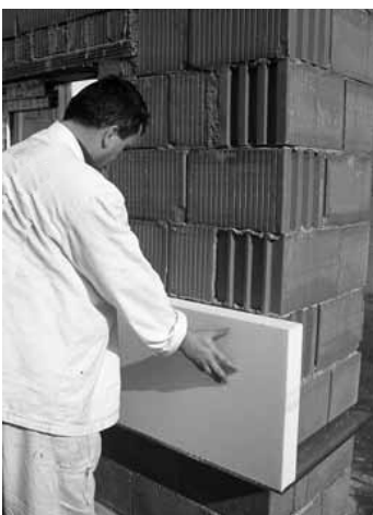
3.5 Založenie prvého radu izolačných dosiek
