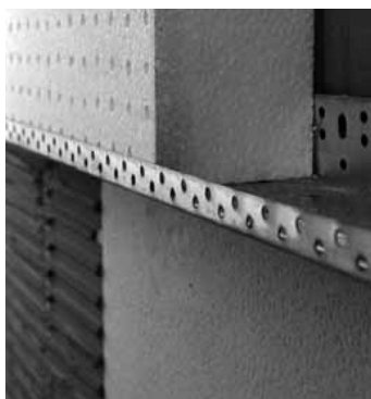
3.6 Detail založenia prvého radu izolačných dosiek
