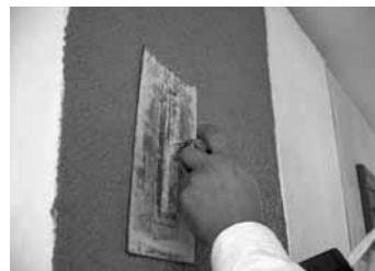
4.16 Vytváranie štruktúry na tenkovrstvovej ušľachtilej omietke
