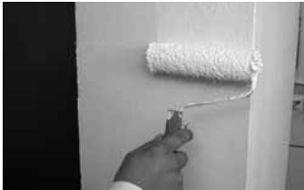
4.14 Príprava armovacej vrstvy penetračným náterom
