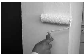
3.22 Príprava výstužnej vrstvy penetračným náterom
