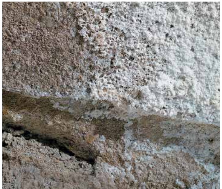
Poškodenie soľou pôsobiacou v hline
