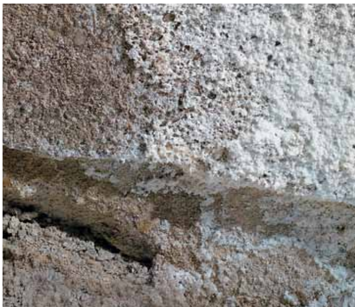
Poškodenie soľou pôsobiacou v hline
