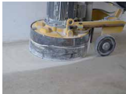
Úprava povrchu brúsením
