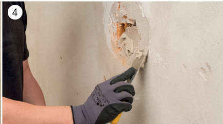
3 Väčšie diery môžeme úplne vyplniť a vyspraviť s Hrubá hladená stierka Durapid XL 25 .
