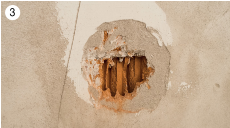
3 Väčšie diery môžeme úplne vyplniť a vyspraviť s Hrubá hladená stierka Durapid XL 25 .
