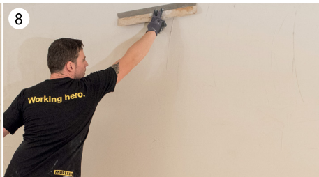
7 Podľa hrúbky nanášanej stierky môžeme použiť Hrubú hladenú stierku Durapid XL 25 ale jemnú hladenú stierku Durapid XS 40 .
