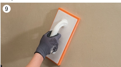
9 Po 60 až 70 minútach môžeme povrch stierky navlhčiť plstným hladidlom. Navlhčený povrch vyhladíme hladidlom tak aby sme odstránili všetky nerovnosti.
