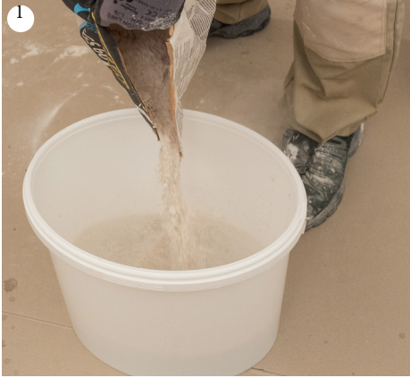
1 Sadrovú stierkovú hmotu nasypeme do vedra s čistou vodou.
