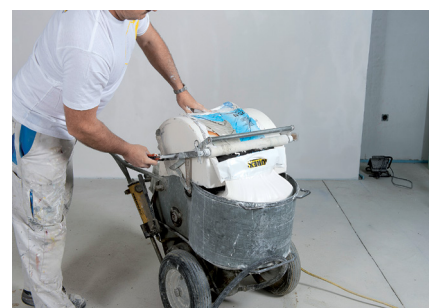
Vyprázdnenie obsahu vreca pomocou ručnej kľuky
