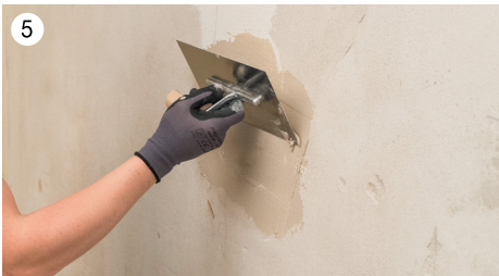
5 Menšie nerovnosti taktiež vyspravíme s Hrubá hladená stierka Durapid XL 25 . Po vyspravení nerovností môžeme pristúpiť k celoplošnému stierkovaniu.
