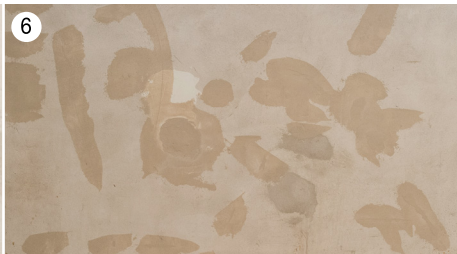
5 Menšie nerovnosti taktiež vyspravíme s Hrubá hladená stierka Durapid XL 25 . Po vyspravení nerovností môžeme pristúpiť k celoplošnému stierkovaniu.
