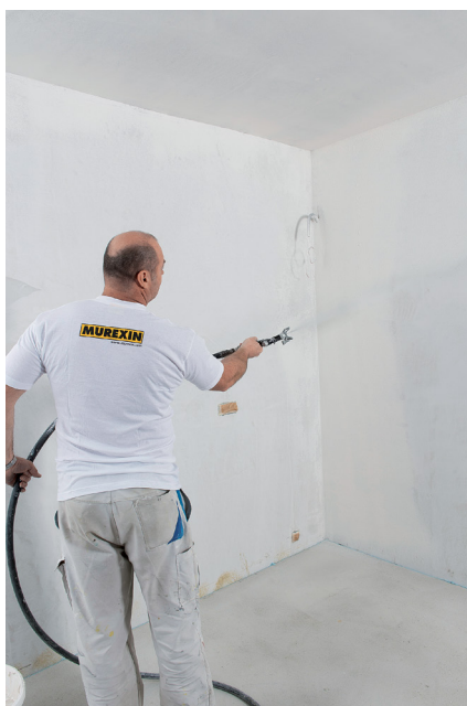
Strojné nanášanie Striekaná stierka Gullspack S 70
