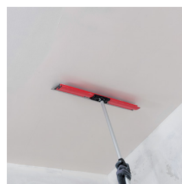
Vyhladzovanie stierky na strope pomocou stierky s nadstavcom
