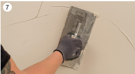
7 Podľa hrúbky nanášanej stierky môžeme použiť Hrubú hladenú stierku Durapid XL 25 ale jemnú hladenú stierku Durapid XS 40 .
