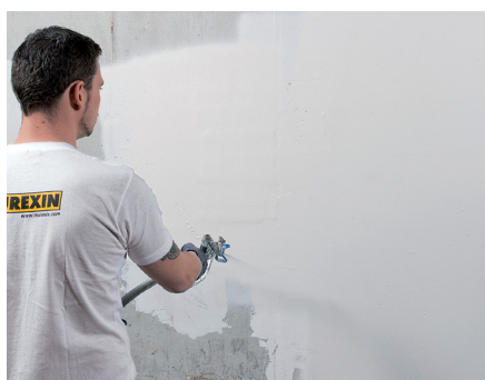
Nanášanie v požadovanej vrstve do 5mm
