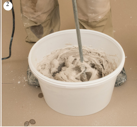
2 Chvíľu necháme prášok nasiaknuť vodou a následne hmotu rozmiešame do hladka pomocou elektrického miešadla.
