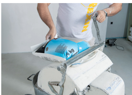
Vloženie vreca do stroja na striekanie
