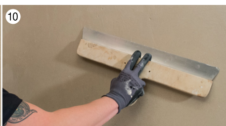
9 Po 60 až 70 minútach môžeme povrch stierky navlhčiť plstným hladidlom. Navlhčený povrch vyhladíme hladidlom tak aby sme odstránili všetky nerovnosti.
