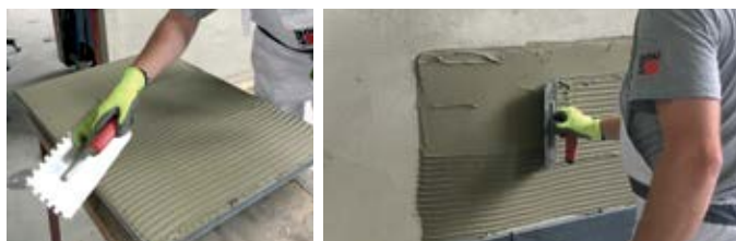
• obojstranné lepenie dlaždíc (tzv. Battering-Floating), lepiaca malta min. triedy C2TES1 - EN 12004
