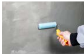
• penetrovanie armovacej vrstvy - Hĺbkový základ LF 1
